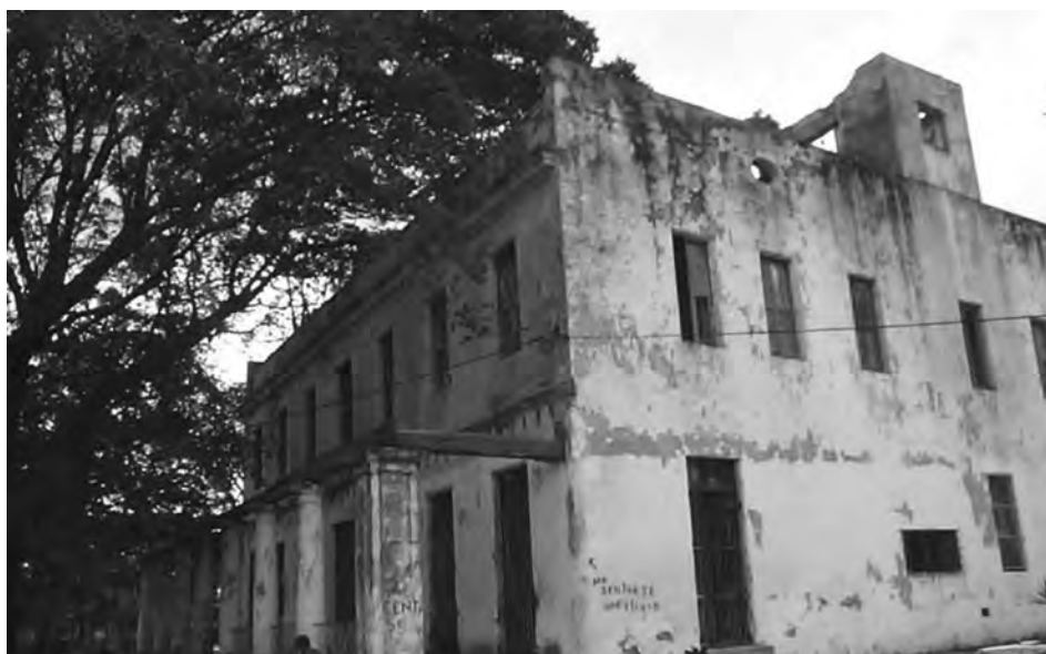
Casa de Los Curas. Se adaptó para el combate (casa fuerte). En su campanario se instaló un heliógrafo. Foto actual.
