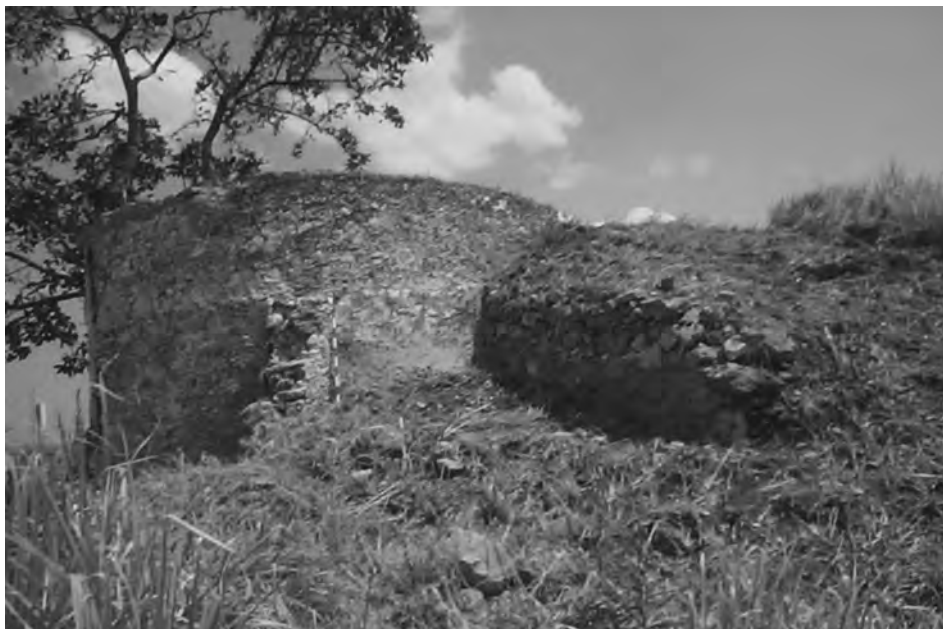
Tramo del camino cubierto que servía de enlace entre la casa del Americano y casa de Los Curas. Foto Actual.
