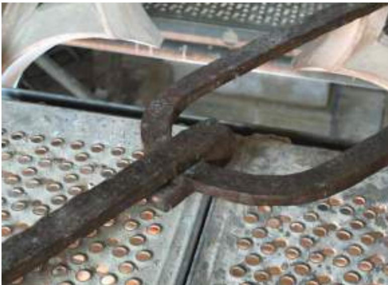
Tensors de ferro en diagonal afegits al segle XVI
