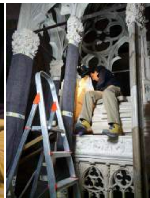
Eliminació del morter de guix que unia el frontal amb les laudes sepulcrales del sarcòfag i els frisos laterals
