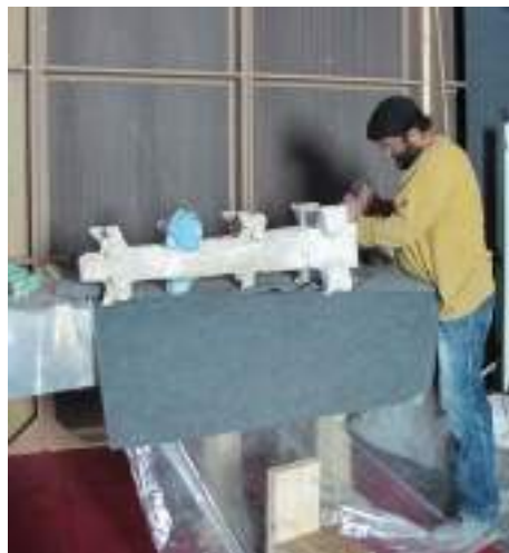
Treballs de creació i col·locació les noves peces realitzades pel picapedrer
