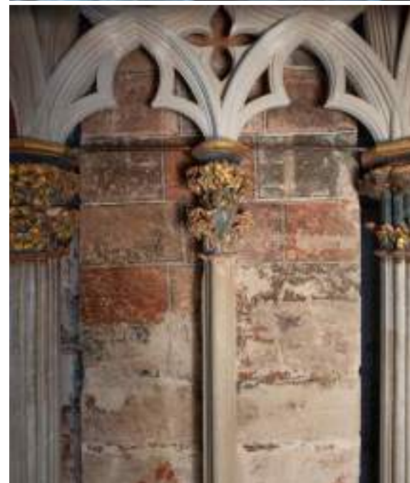
Decoració a base de carreus pintats, conservada a la paret del pilar de l'església
