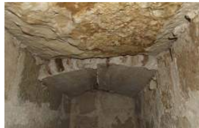
Detall des de l'interior de la coberta en volta de maons disposats a plec de llibre (extrem est)
