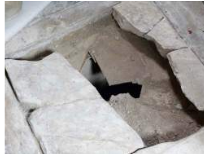
Extrem oest. Coberta de rajoles a manera de volta catalana
