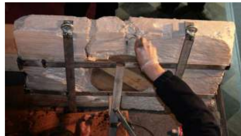
Procés de col·locació de l'estructura d'acer per subjectar el frontal renaixentista
