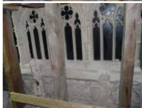
Desmuntatge de les columnetes de suport del frontal d'alabastre malmeses a causa de l'oxidació dels pernns d'unió de ferro
