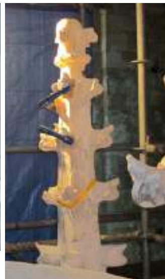
Treballs de creació i col·locació les noves peces realitzades pel picapedrer
