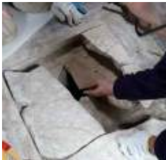
Extracció de les peces que conformaven la volta de rajoles existent a l'extrem oest
