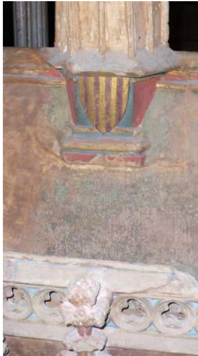
Pintat en color ocre ataronjat de les reparacions de guix blanc realitzades per Mestre i Hernández Sanahuja (tapa i pinacle de l'urna, junta de la tapa del sarcòfag)
