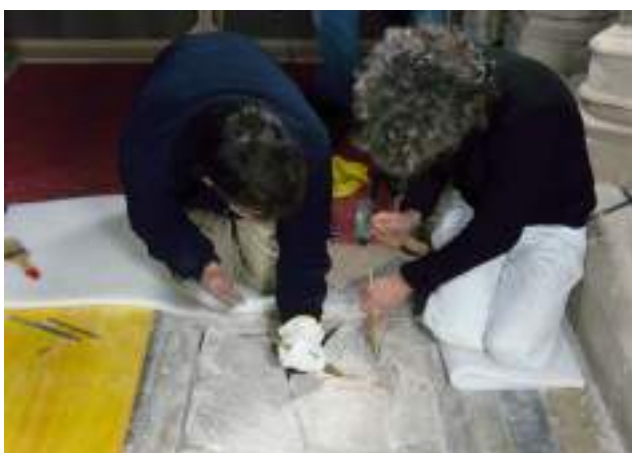
Treballs d'eliminació dels fragments de morter de rejuntat afegits
