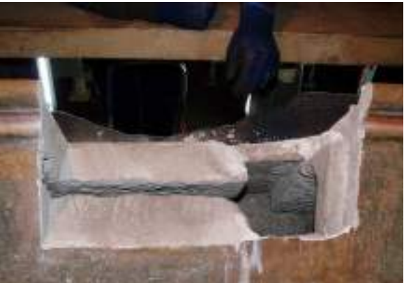
Elements de reconstrucció presents a la tapa de l'urna i constituïts per maó i guix, un material no original utilitzat durant la intervenció de 1856
