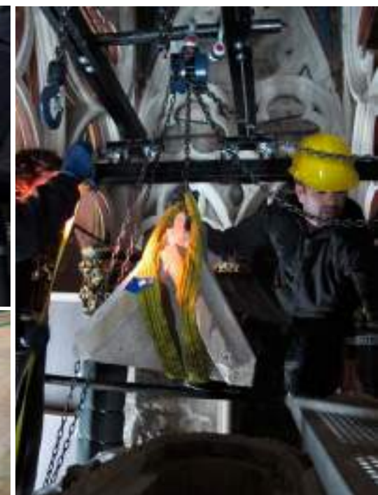
Treballs de desmuntatge de la tapa de l'urna
