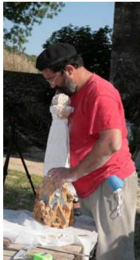
Fabricació i col·locació de les parts del pinacle realitzades pel picapedrer
