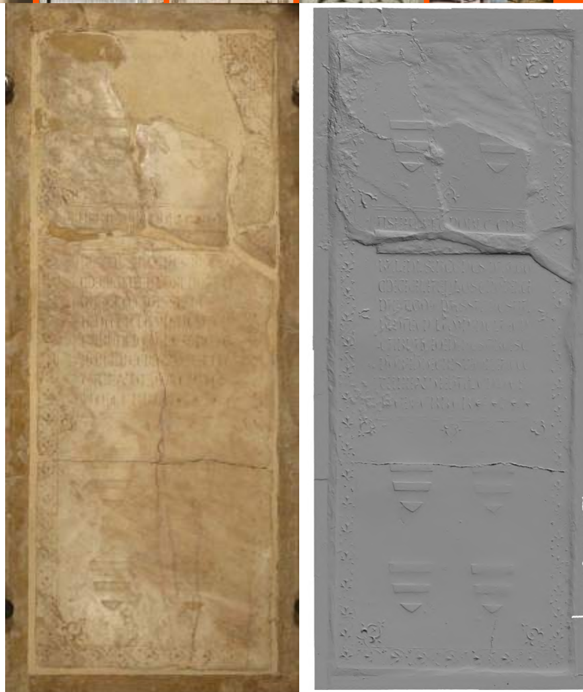
Fotografia i aixecament en 3D de la làpida de Roger de Llúria abans d'iniciar l'aixecament per a la restauració
