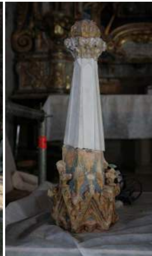
Fabricació i col·locació de les parts del pinacle realitzades pel picapedrer
