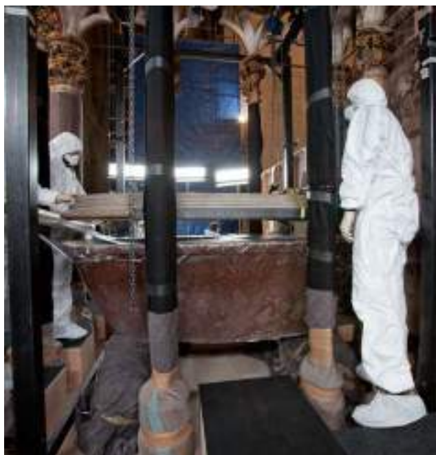
Procés d'aixecament de la llosa
