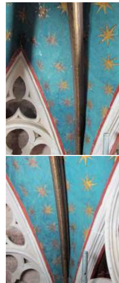
Treballs de fixació de la pel·lícula pictòrica de l'interior de la volta. Abans i després
