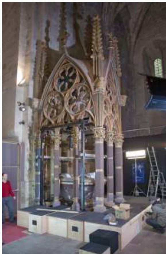
Tarima col·locada a l'entorn de la tomba per facilitar els treballs d'aixecament de la llosa i d'observació de les restes
