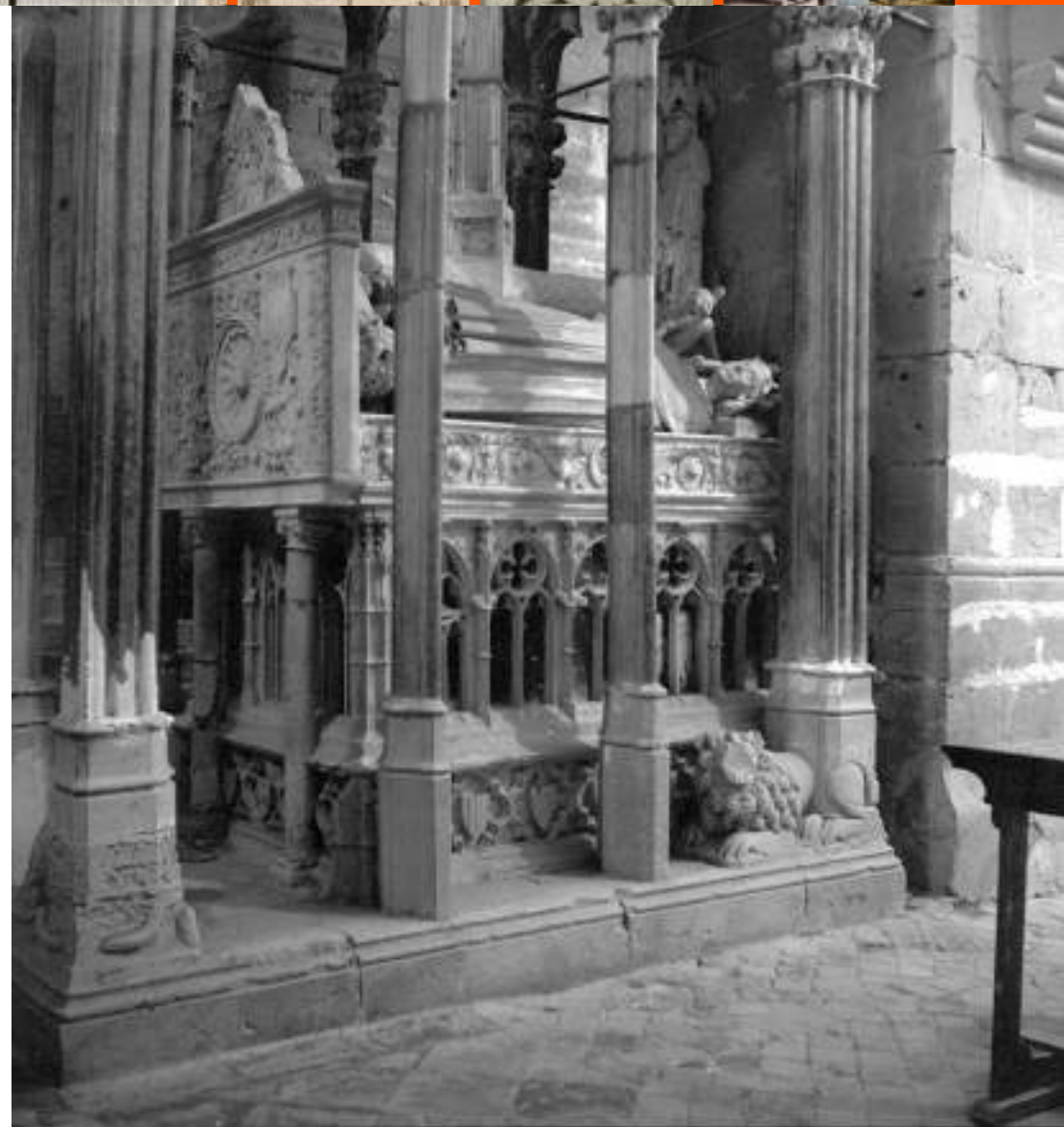
Fotografia de Cuyàs on es veu la construcció de les dues columnes a partir dels fragments trobats; s'hi poden observar també els desperfectes en les bases de les columnes provocats en retirar la barra de ferro. Vers 1950
