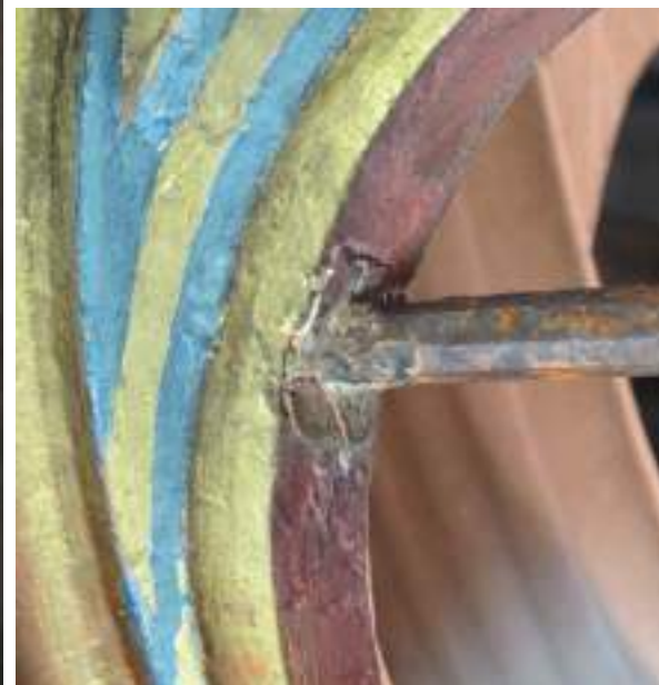
Detall dels tirants de ferro que subjecten l'estructura del baldaquí
