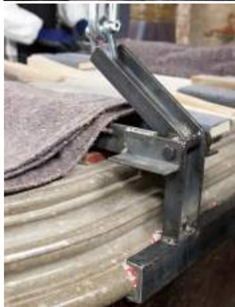
Protecció i fixació de la llosa per a l'aixecament
