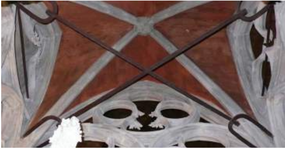
Tensors de ferro en diagonal afegits al segle XVI
