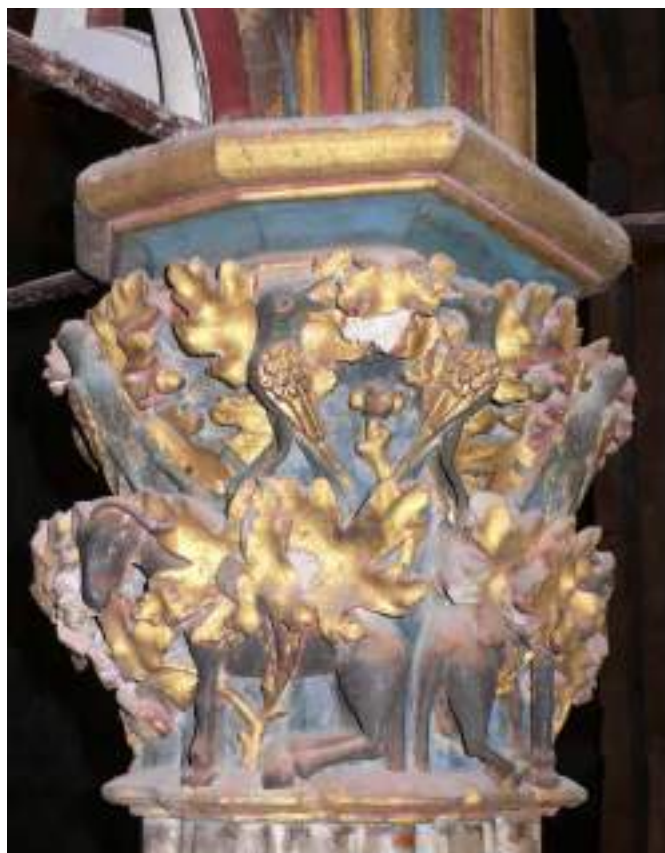
Detalls de les zones decorades amb làmines de plata ennegrides per l'alteració natural del metall
