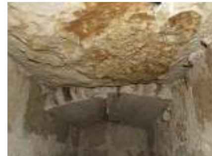
Volta constituïda per maons disposats a plec de llibre que cobria l'extrem est de la tomba
