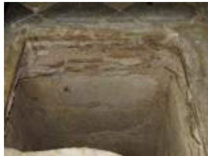
Detall del punt on recolzava la volta de rajoles existent a l'extrem oest
