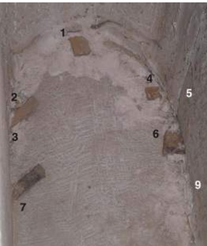
Numeració de les diverses falques. En negre, les que foren reposades al seu lloc durant la restauració. En blanc les que quedaren en dipòsit al MHC
