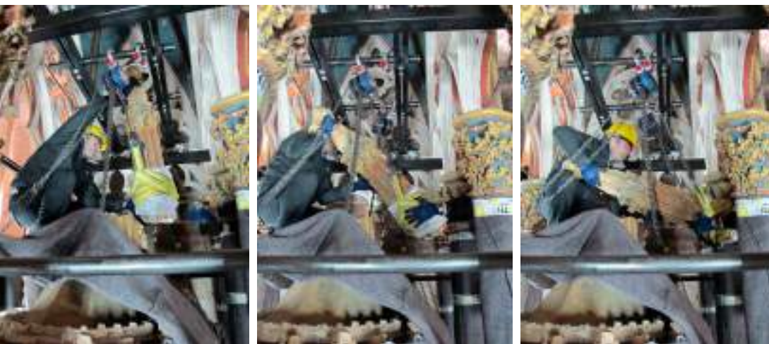
Procés de desmuntatge del pinacle
