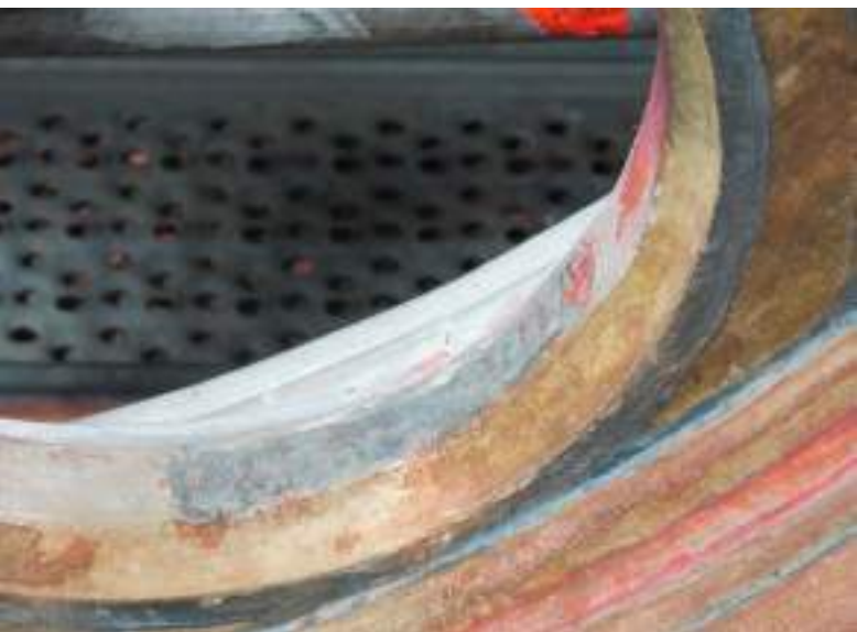
Detall de les grapes d'unió de ferro cobertes de plom entre les formes de pedra de les traceries, als cercles i a les formes lobulades
