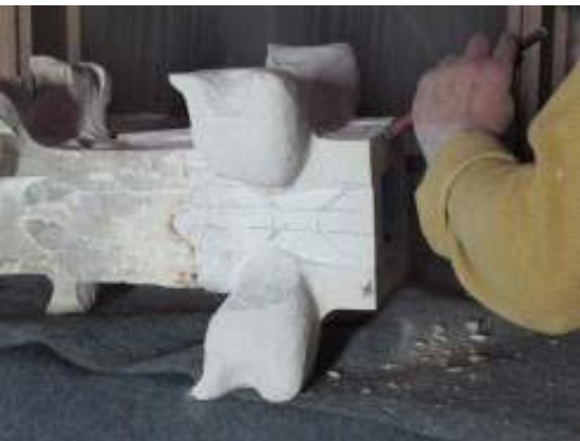
Treballs de creació i col·locació les noves peces realitzades pel picapedrer
